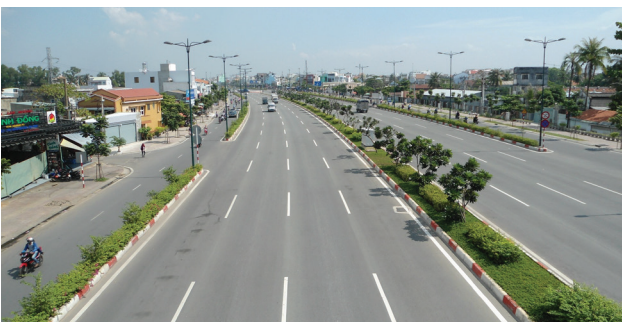
Dự án Tân Sơn Nhất - Bình Lợi Ứng dụng: đệm cát gia cố xi măng & cọc xi măng đất
