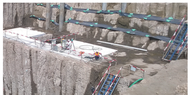
Duyên Hải 3 - Nhà máy nhiệt điện mở rộng Ứng dụng: gia cố nền bằng cọc xi măng đất
