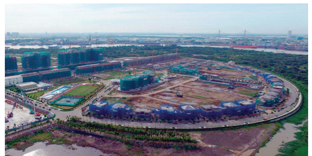
Chung cư Đại Quang Minh Ứng dụng: đệm cát gia cố xi măng & cọc xi măng đất
