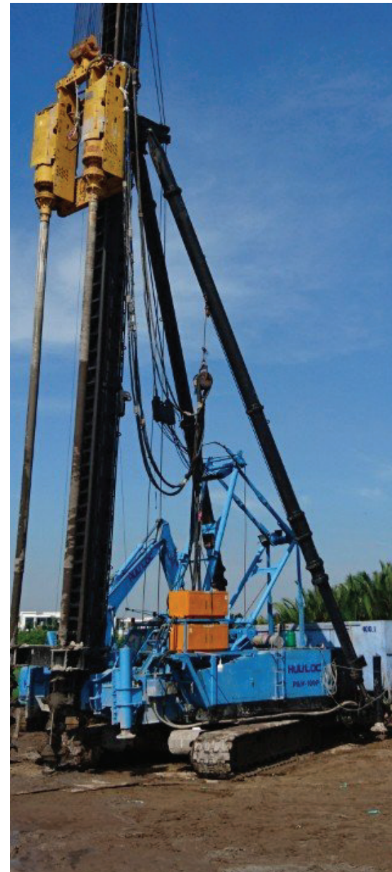
Hình: khoan cọc xi măng đất
